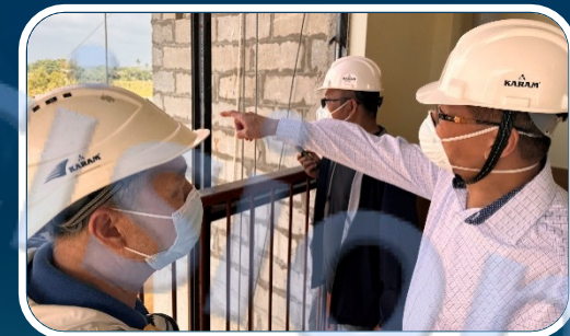
訪視 印度廠區 員工 宿舍工程 進度
